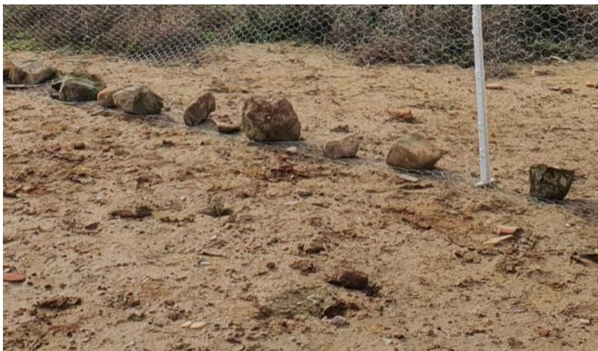
Vallado temporal con malla de triple torsión. El solape horizontal de la malla sobre el suelo, aunque fijado con piedras, no se ha recubierto con tierra, lo que facilita que los conejos comiencen a excavar desde su borde. Además el solape se debe orientar hacia la zona donde están las madrigueras, no hacia el interior del cultivo como ocurre en la fotografía.
