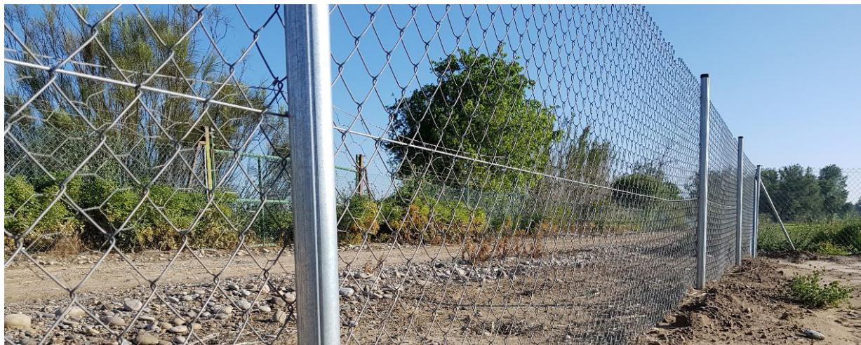
Vallado permanente con escasa altura de protección. Aunque ambas mallas (simple y triple torsión) penetran verticalmente en el suelo, esta última sólo asciende hasta los 50cm sobre el nivel del suelo. Los conejos más jóvenes pueden trepar y pasar a través de la malla de simple torsión desprotegida, tal y como indican los excrementos y escarbados que hay dentro del vallado.
