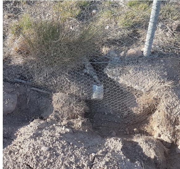
Vallado permanente con malla enterrada verticalmente en el suelo. La malla enterrada verticalmente ofrece protección frente al paso de conejos por debajo del vallado en ambas direcciones. En el caso de la foto, no obstante, únicamente profundiza en el suelo la malla de triple torsión, quedando la de simple torsión a ras de suelo. La eficacia del vallado disminuirá conforme la malla de triple torsión se vaya debilitando por corrosión y vaya siendo rota por los conejos.
