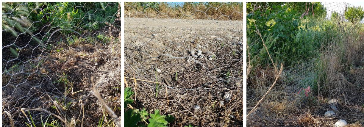
Típicos orificios realizados por conejos en vallados temporales construidos con malla de triple torsión. Este tipo de vallados requieren de un mantenimiento y parcheado frecuente, ofreciendo una protección que declina rápidamente con el tiempo.
